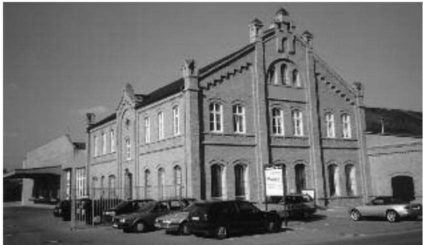
Am 30. Juni 1995 wurden Teile der ehemaligen Hoffmann-Werke unter Denkmalschutz gestellt. Der jetzige Besitzer ließ die Gebäude sorgfältig restaurieren
