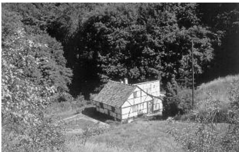
Das „Haus im Loch“ vor der Restaurierung. Die Aufnahme entstand im Jahre 1948
