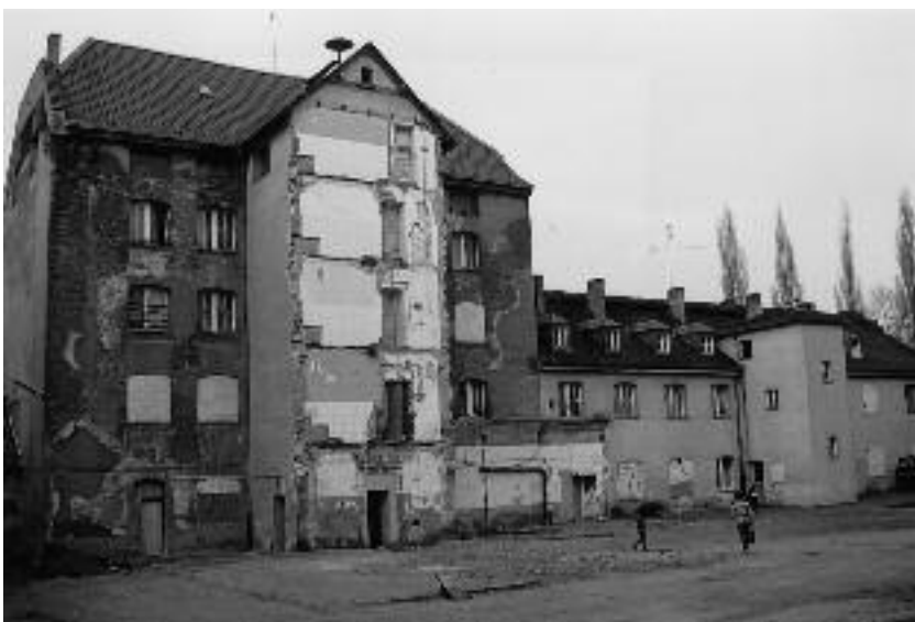
Das Fabrikgebäude (Hinterseite) 1983 vor der Entkernung. Rechts alte Werkstattgebäude und Arbeiterwohnungen
