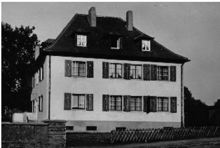
Die sogenannte Bürgermeistervilla an der Kaiserswerther Straße 16
